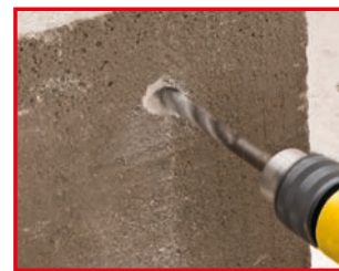
Perfuração em concreto
