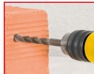
Perfuração em alvenaria
